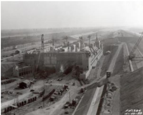
La centrale comprend 4 groupes turbines verticaux « Kaplan », qui développent une **puissance de 180 MW** grâce à une **hauteur de chute de 15,70 m**. C'est la centrale la plus puissante de
